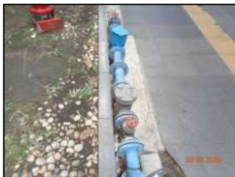
รูปที่ 2-28 การเชื่อมต่อประปาของโครงการกับท่อประปาชุมชนสุขุมวิท
