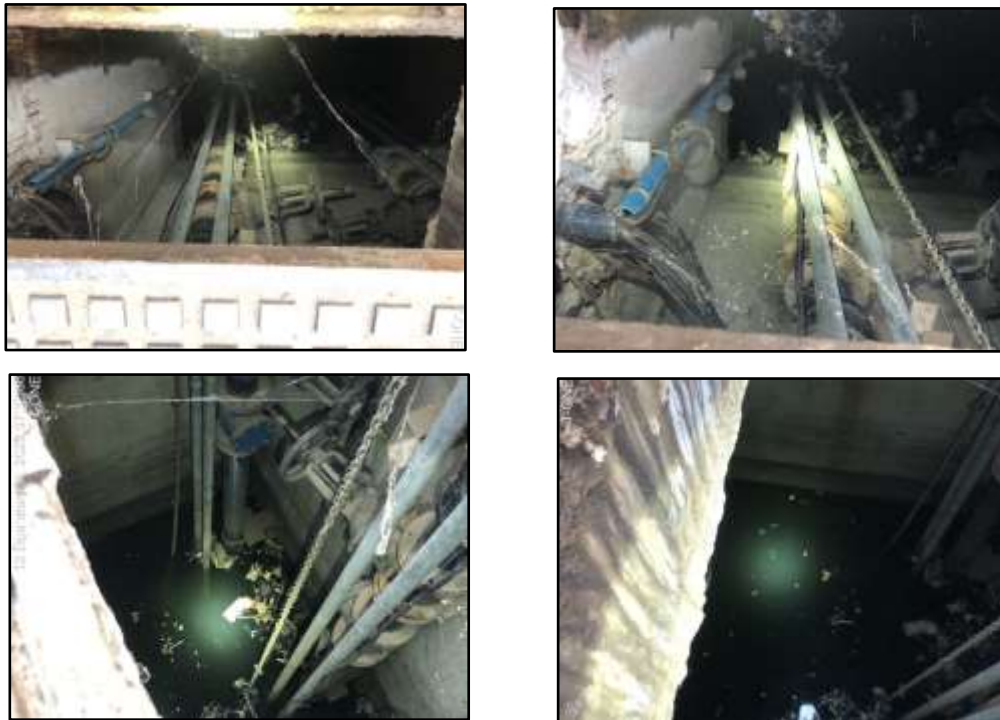
รูปที่ 2-44 เครื่องสูบน้ำเพื่อควบคุมอัตราการระบายน้ำฝนออกจากบ่อหน่วงน้ำ
